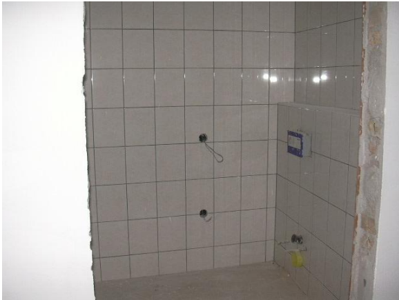
Földszint mozgássérült vizesblokk lapozva, csempézve
