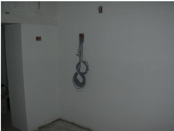
Földszint meszelt fal és fűzött vezeték vég
